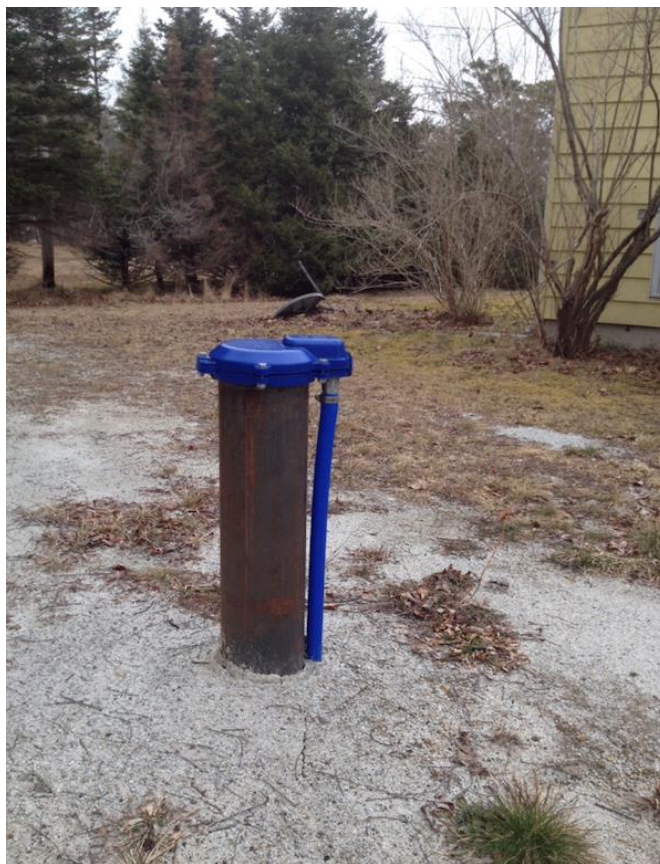
Рисунок 4 - Пробуренная скважина для частного дома, на которой видны обсадка скважины, электрическая линия для погружного насоса и крышка скважины (фотография John Drage).
