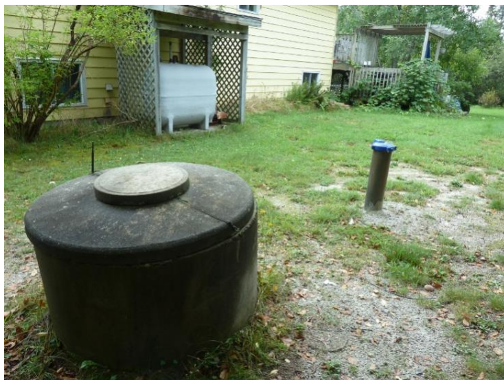
Рисунок 16 - Две бытовые скважины, расположенные рядом с резервуаром для домашнего печного топлива. Этот пример показывает, как бытовые скважины могут быть подвержены множественным уязвимостям, включая засухи и источники загрязнения. Вырытый колодец (слева на переднем плане) был заменен на глубокий пробуренный колодец (справа, с синей крышкой колодца), потому что сезонные засухи часто приводили к тому, что этот неглубокий вырытый колодец высыхал. Оба колодца расположены рядом с резервуаром для печного топлива (серый резервуар рядом с домом), который может загрязнить колодцы, если произойдет утечка или разлив масла (фотография John Drage).
