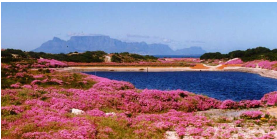
Figura 14 - Balsa costera de recarga para disposición de aguas residuales industriales tratadas (DWAF, 2010).
