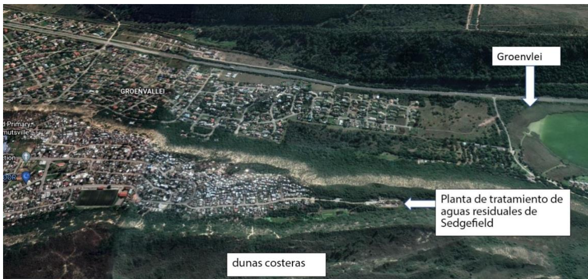
Figura 47 - Trabajos de la planta Sedgefield de tratamiento de residuos en las dunas de arena, con Groenvlei en el primer plano (Murray and Ravenscroft, 2010).
