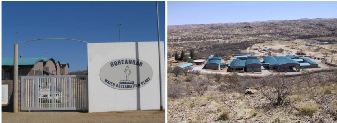
Figura 31 - Nueva Planta de Recuperación de Agua de Goreangab (van Rensburg, 2006).
