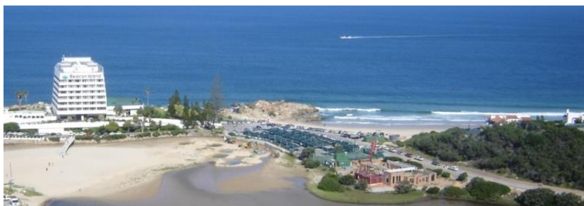
Figura 46 - Planta desalinizadora de Plettenberg Bay– junto al icónico Beacon Isle Hotel de la ciudad (Veolia, 2019).
