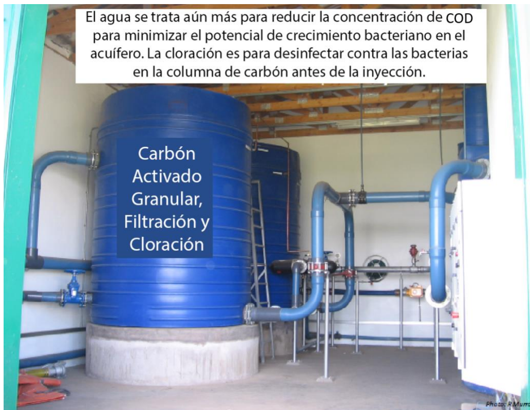
Figura 32 - Tratamiento final de la Fuente agua (Murray, 2017).
