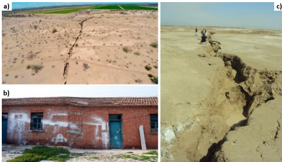
شکل 2-5: نمونه‌هایی از ترک و شکاف‌های زمین به دلیل پمپاژ آب‌های زیرزمینی، a - آریزونا، آمریکا
