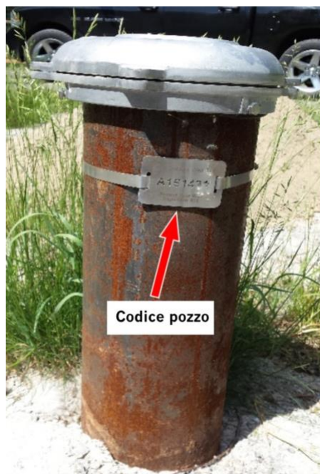
Figura 2 – Pozzo perforato in Ontario, Canada, con targhetta affissa sul rivestimento indicante un codice univoco (ID).
